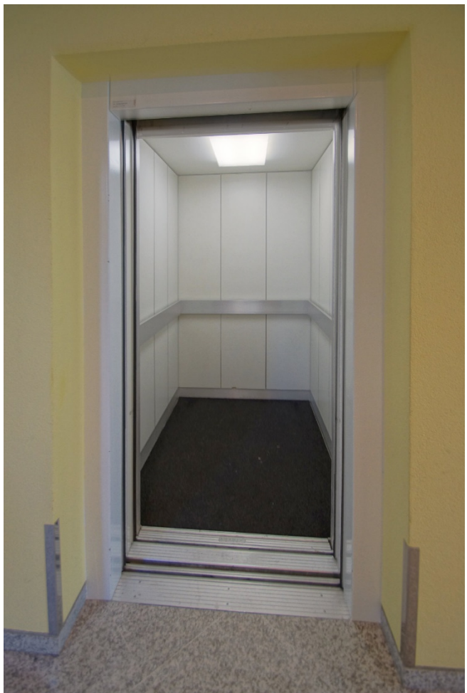
Abbildung 46 - Der unumgängliche Lift nach oben
