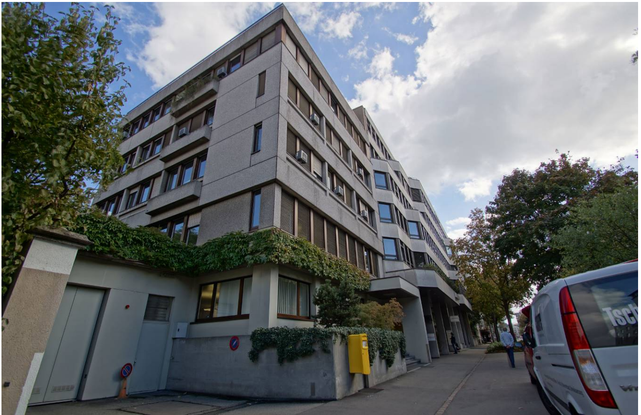
Abbildung 29 - Steinengraben - Beispiel modernistischer Architektur?
