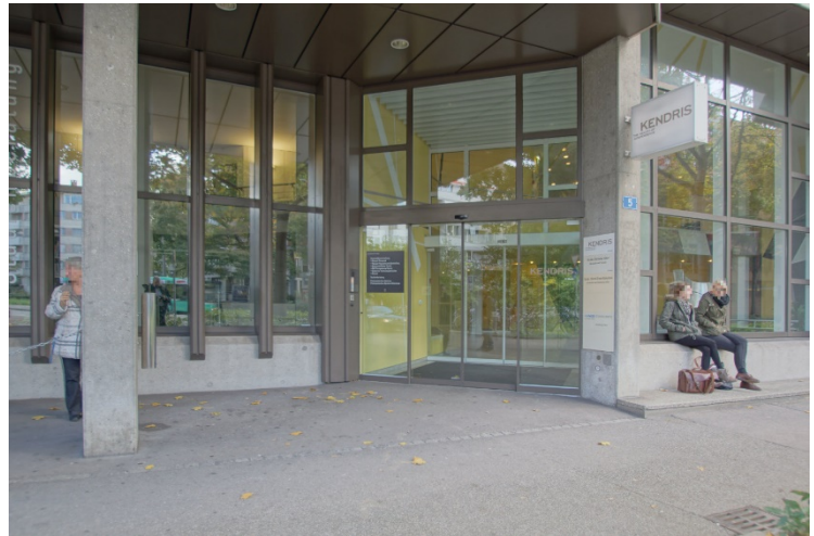
Abbildung 21 - Eingangsbereich des Steinengrabens 5
